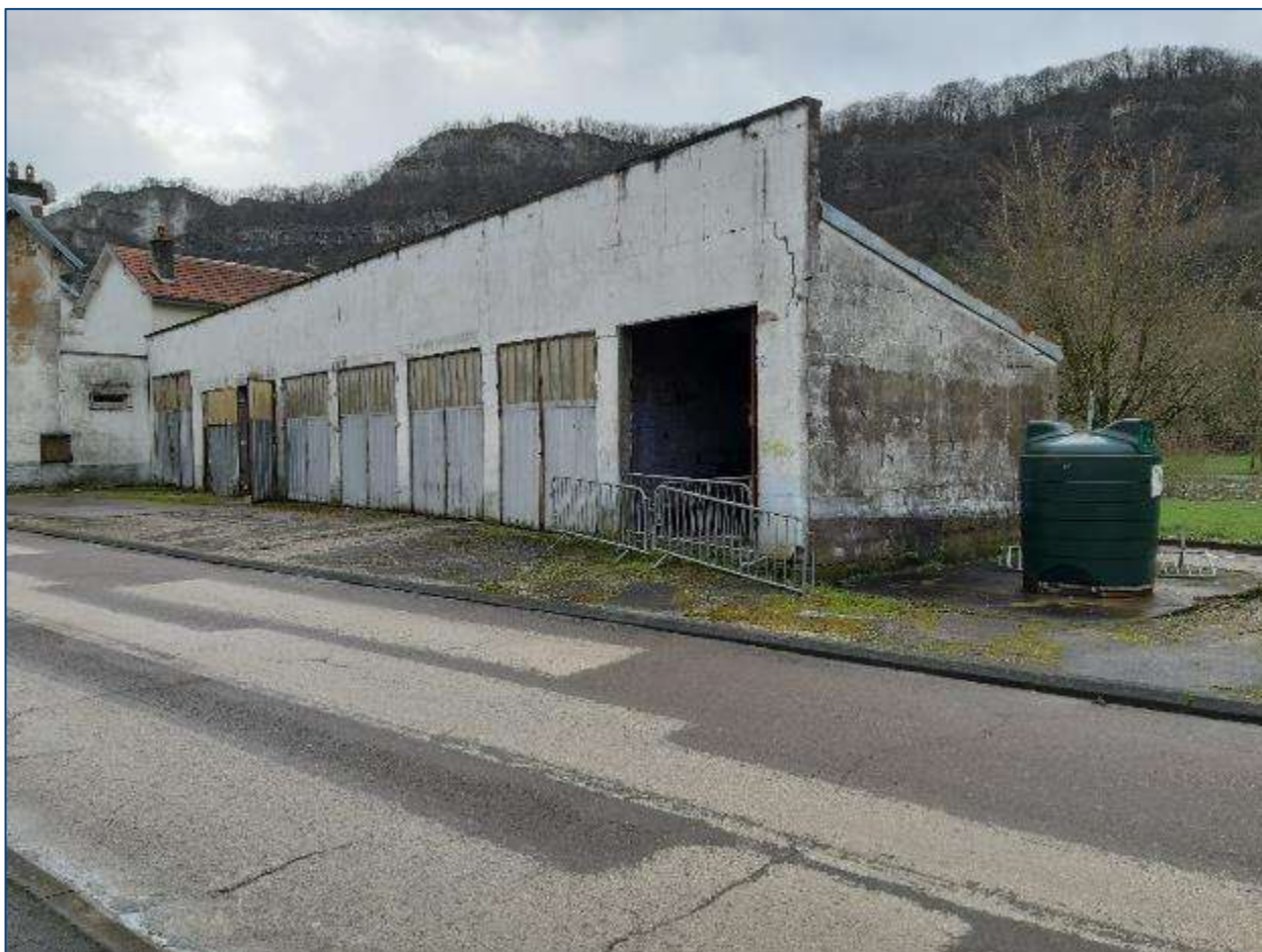
Figure 47 : Vue d'ensemble du site d'implantation du PR Cour au 14 février 2020
